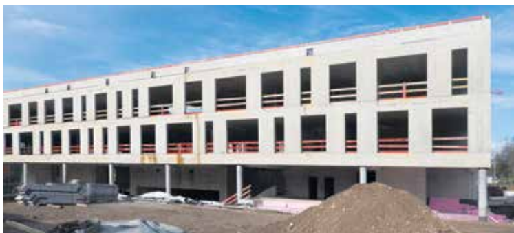
Der Neubau der Goetheschule kommt voran
