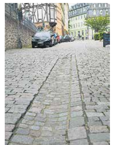
Hauser Gasse – barrierefreies Laufband im Pflasterbelag
