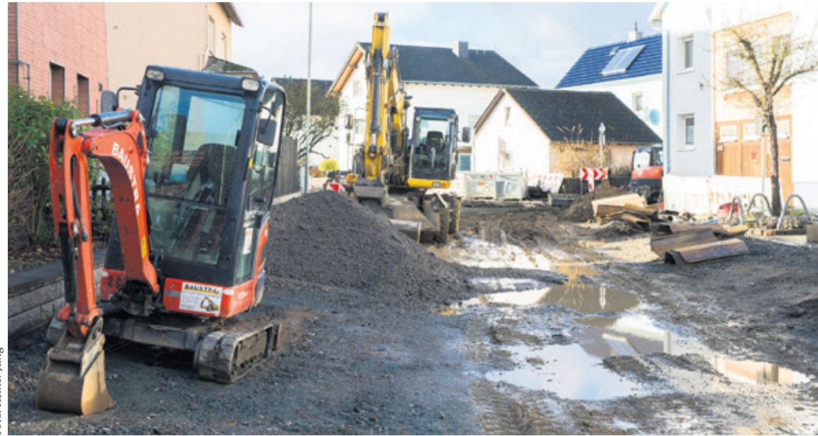
Grundhafte Erneuerung der Wetzlarer Straße in Münchholzhausen
