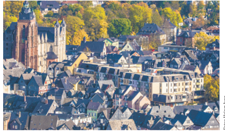
Das Stadthaus am Dom wird neu gestaltet
